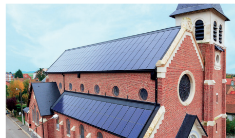
Loos-en-Gohelle - Panneaux solaires sur le toit de l'église
