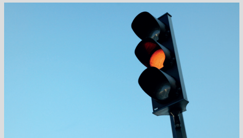
Installation de feux tricolores intelligents
